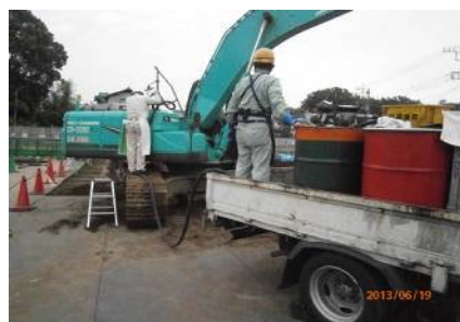
建設現場の発電機・重機類のBDF給油作業
